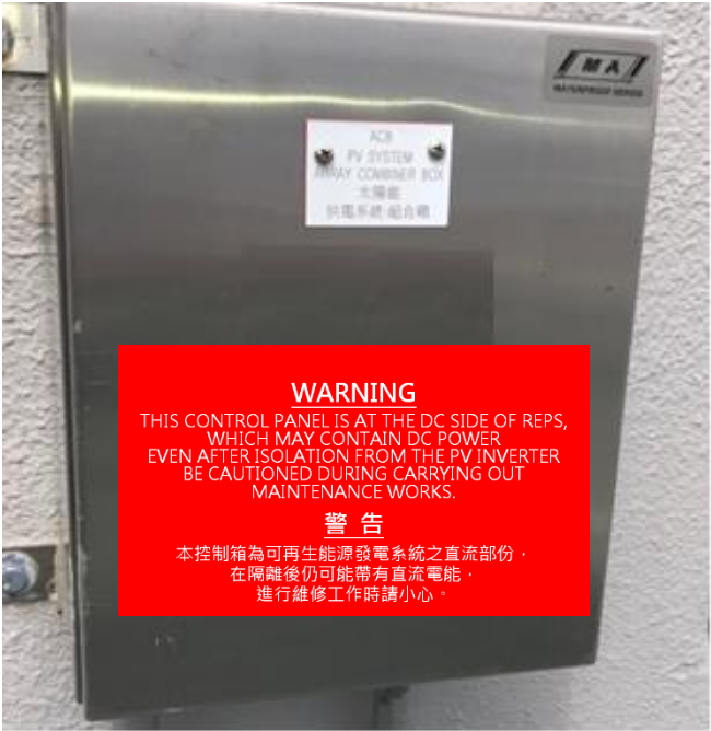
DC switchgear
