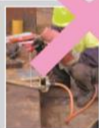
使用易燃物品時，須有適當防火及滅火設施，和不准使用明火工序及吸煙
